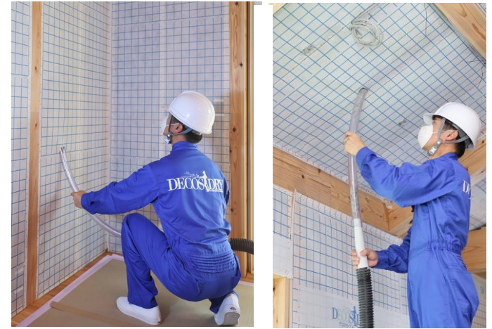
セルローファイバー断熱材の施工状況
