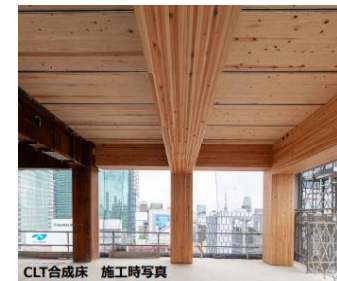
CLT合成床 施工時写真
