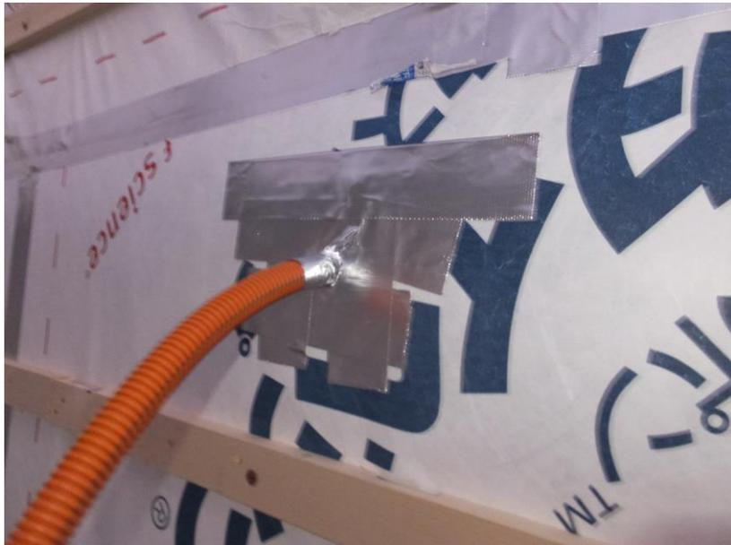
電線管とか設備の管の回りの処理も大切です。
