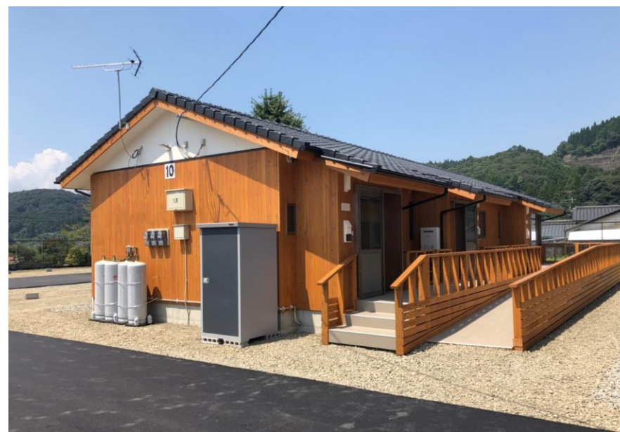
熊本豪雨（ベタ基礎・瓦屋根に）
